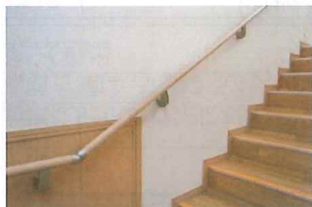
手すりの設置
